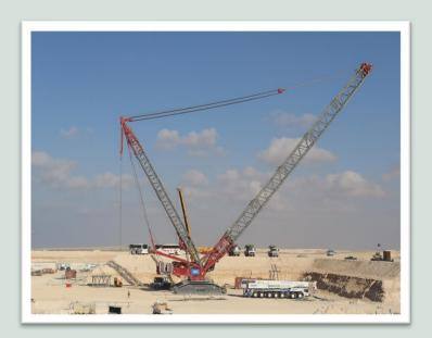
الانتهاء من تجميع أكبر رافعة متحركة بالموقع وكذلك اتمام عمليات الاختبار والتشغيل لها لحمل وتركيب مصيدة قلب المفاعل بالوحدة النووية الأولى
